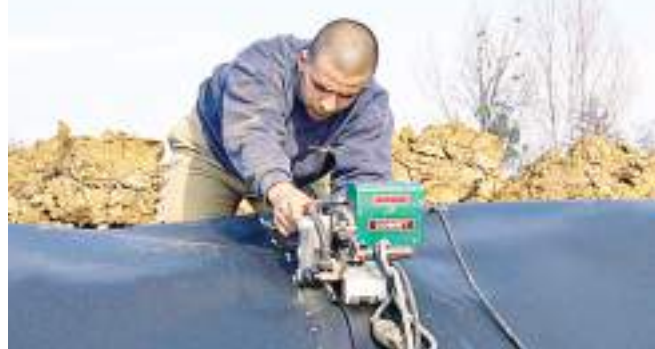
... на обустройстве полигона
